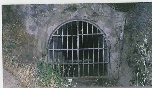
Los cierres inadecuados impiden que muchas especies puedan utilizar las cavidades.
