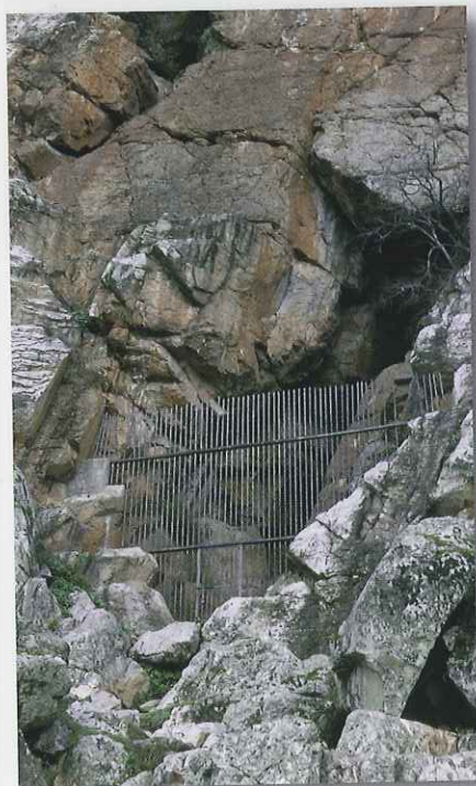
En el cerramiento a 3/4, queda libre la parte superior de la entrada.
