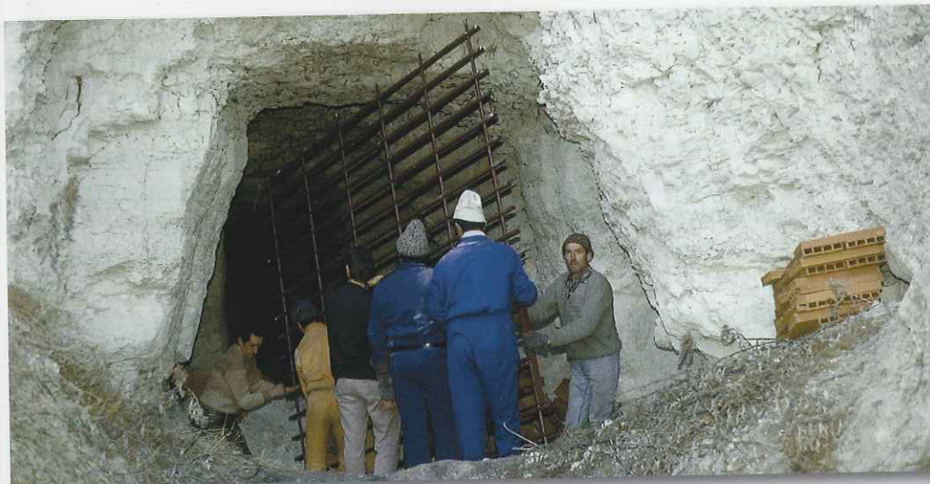
Colocación de un enrejado especial para murciélagos, con el fin de evitar el vandalismo que se producía en un refugio.
